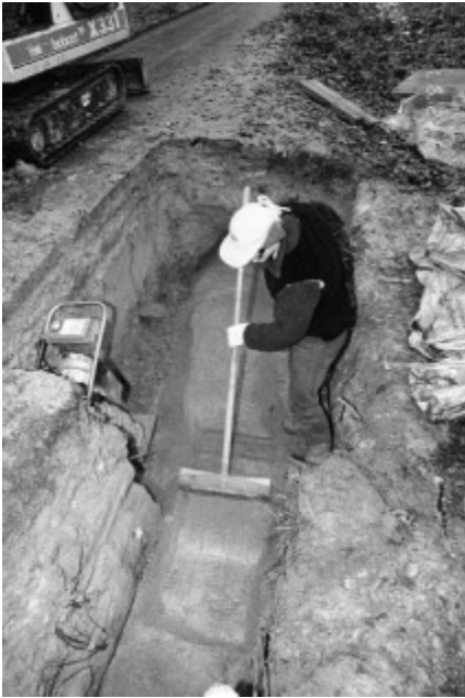
Bild 9. Einbettung des außerhalb des Bohrlochs befindlichen Anodenabschnitts in den Graphitflinz.
