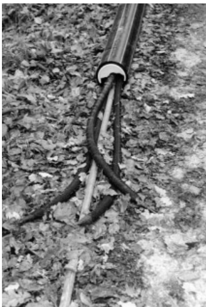
Bild 6. Im HDPE-Schutzrohr vorgerichtete Kabelanoden.
