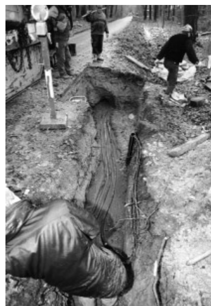
Bild 8. Etwa 5–6 m langer Anodenabschnitt außerhalb des Bohrlochs.
