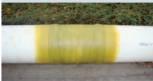
BILD 7: Applikation der Schrumpfmanschette (oben) und fertige Außenlage mit System-AF90
