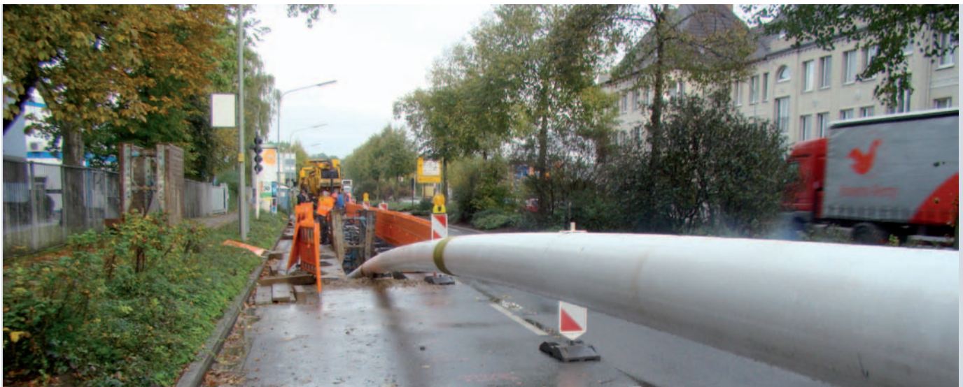
BILD 1: Grabenloser Rohreinzug im HDD-Verfahren
