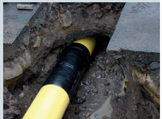
BILD 5: Horizontalspülbohrung mit dem Dirax-System
