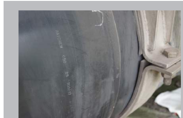
Bild 7: HSP/Raychem-Schrumpfmanschette
